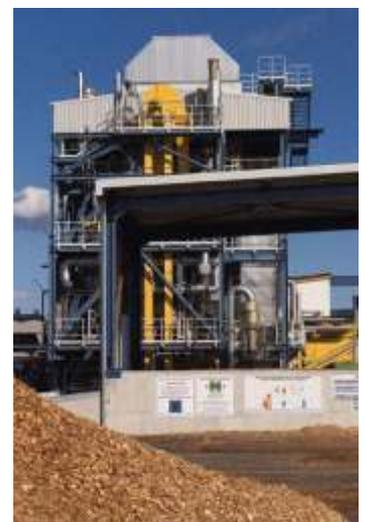
Biomassekraftwerk Güssing - erzeugt Holzgas aus Holzhackschnitzeln. Wirkungsgrad: 85%.
