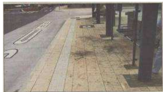
Die Busstation der Öffis an der Pförtmühle vor der professionellen Reinigung ...
